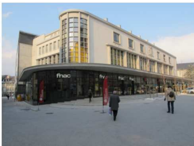
Les Halles de Chambéry
