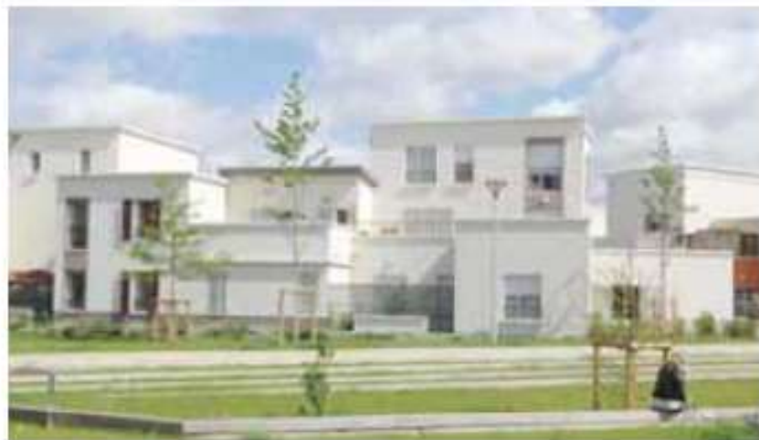
Stains - Crédit photo : Certu
