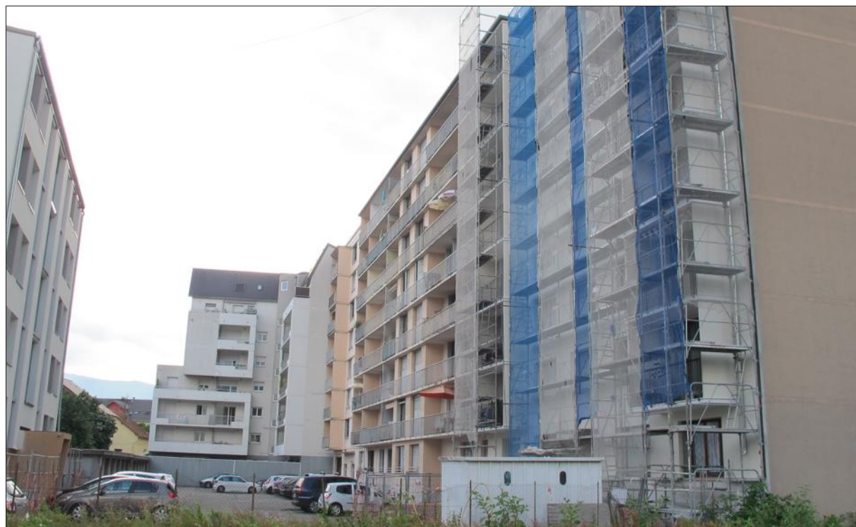
En matière de rénovation énergétique, Métropole Savoie place la barre très haut : 3000 logements et 1600 locaux tertiaires rénovés chaque année. Peu de SCoT affichent un plan aussi ambitieux. Photo archives Le DL
