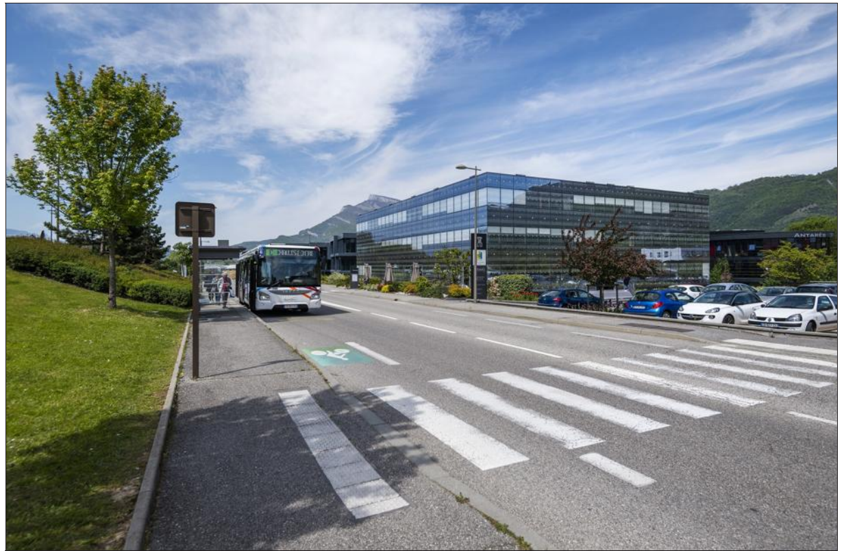
Les parcs d’activités (ici Les Massettes à Challes-les-Eaux) seront connectés aux villes. Photo Métropole Savoie / Yannick SIEGEL
