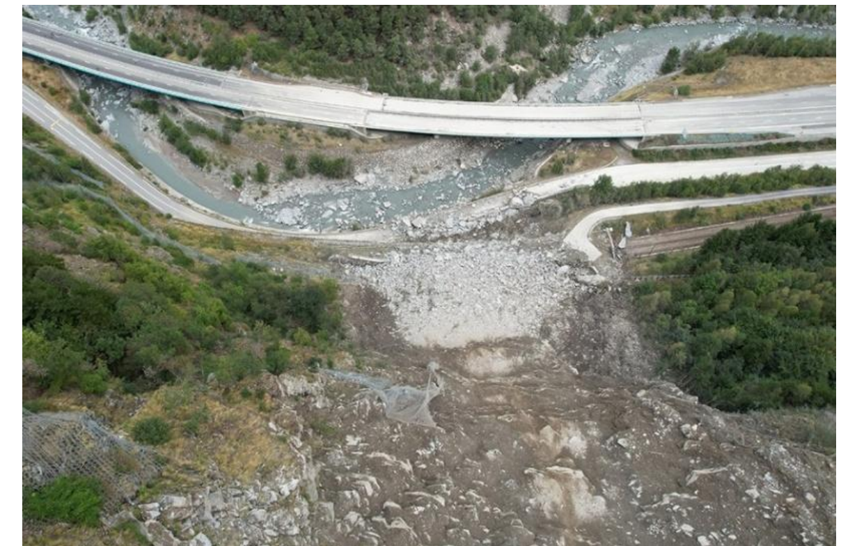
Eboulement de la Praz. Source : CD73
