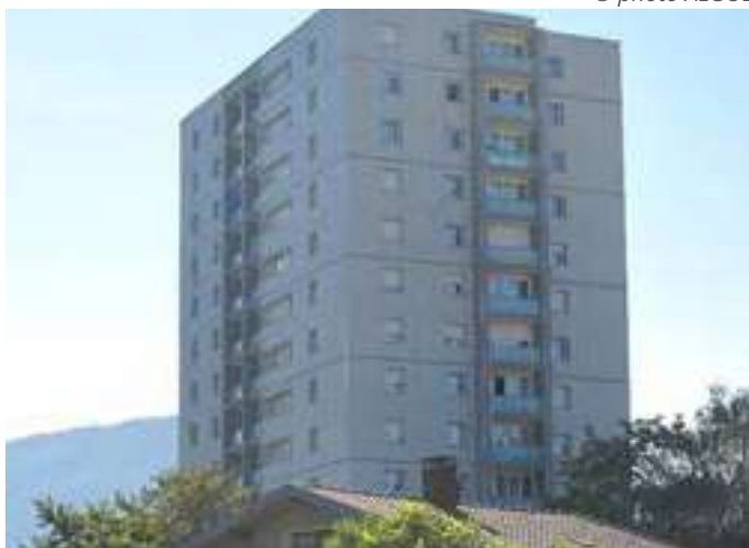
Habitat collectif Aix-les-Bains © photo ALGOE
